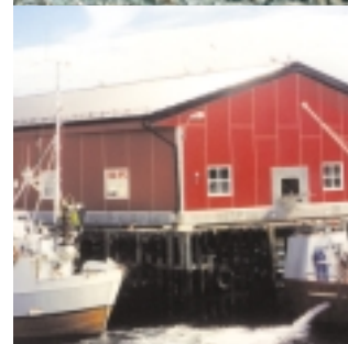
Fra nyanlegget til Gunnar Klo AS på Stø i Vesterålen
